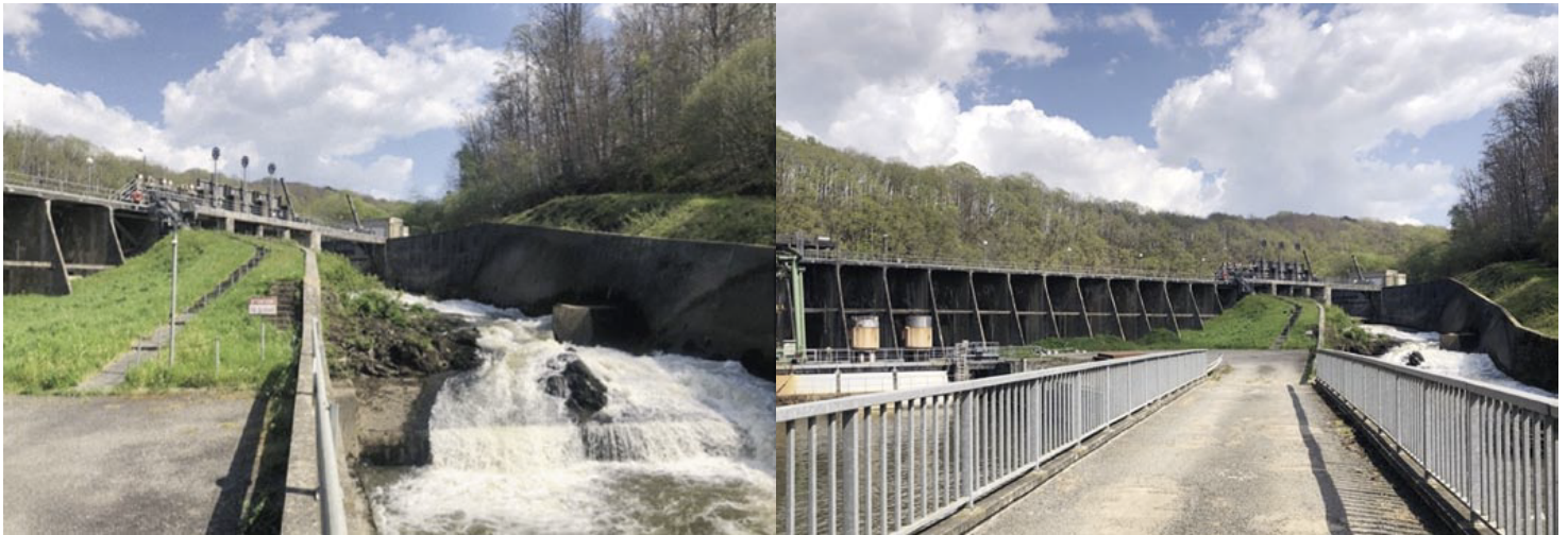
Le barrage de La Roche-qui-Boît (Propriété d'EDF), avec un déversoir à droite et l'usine à gauche.
