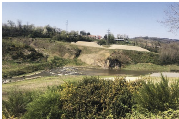
Ancien site du lac réservoir du barrage de Vezin avec les géotubes (au fond en orange) utilisés pour les sédiments et la végétation riparienne couvrant les rives.
